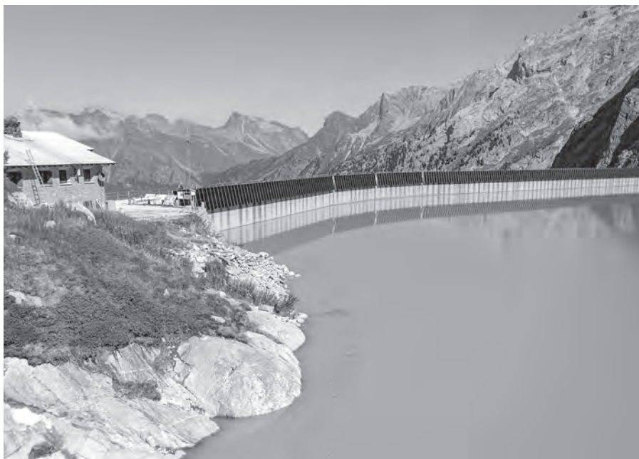
Photovoltaik auf der Albigna-Staumauer, 2020 Felsberg GR Lage: 2162 m ü. M. Fläche: 2176 m 2 Jahresproduktion: 500 MWh Betreiber: Elektrizitätswerk der Stadt Zürich (EWZ)
